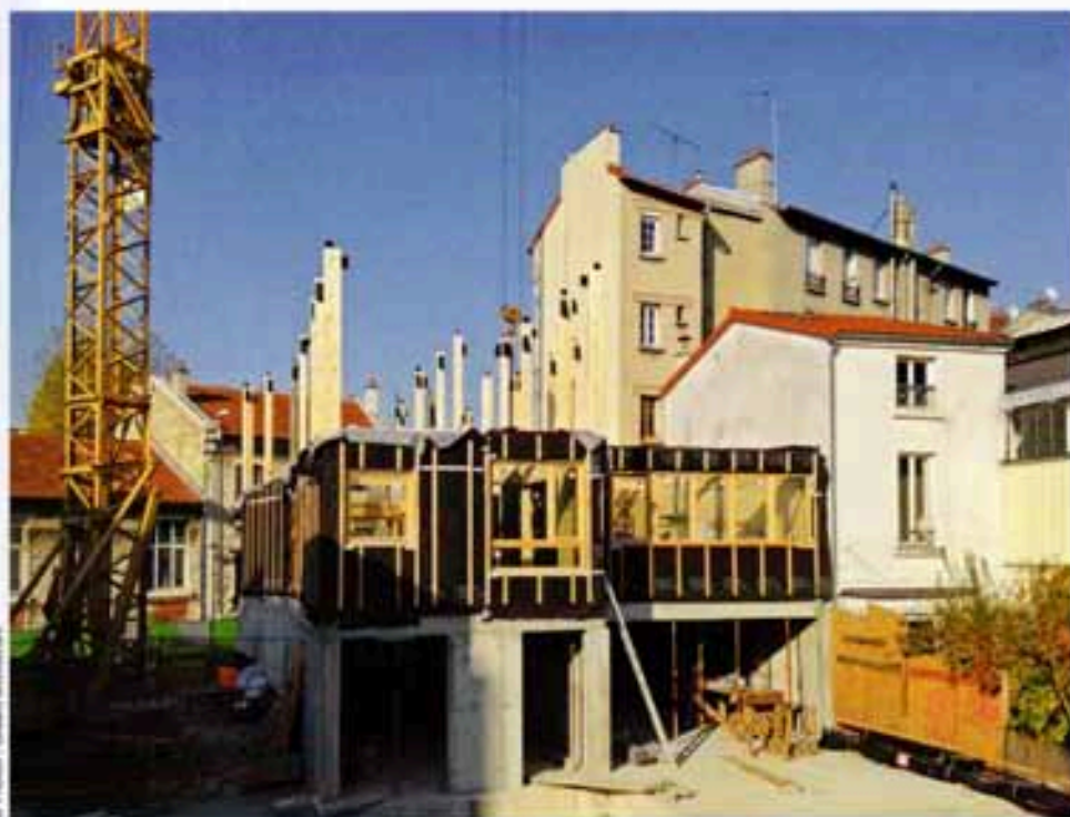
V Montage d'un immeuble de 23 logements, rue Parmentier, Montreuil, Gram architecture.
